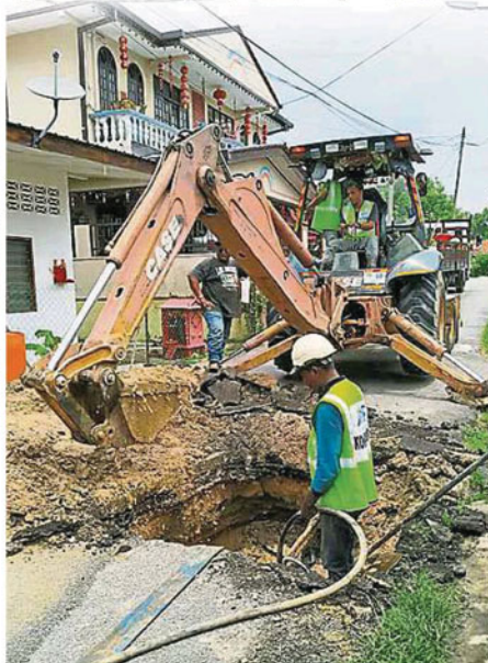
雪州水供公司水色商必须在马路上挖出大洞,才能找到破裂的水管。
